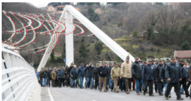
Il ponte intitolato alla Divisione Cuneense.
